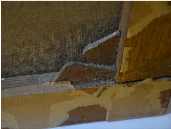
Abb. 3,4.: Arbeitsaufnahmen, trockene Oberflächenreinigung
